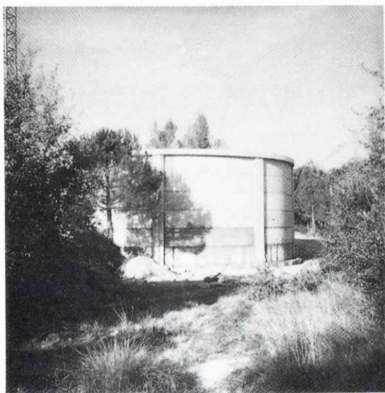
El nou dipòsit d'Aigua de Can Puigdomènech, de 1.000 m. 3 , de cabuda.
