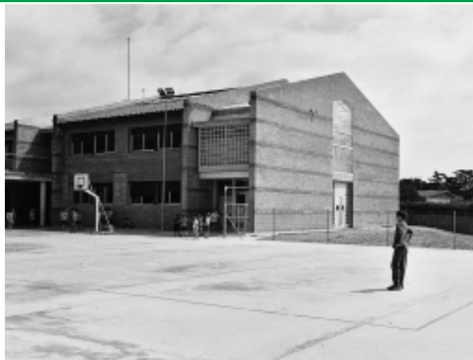
Les obres del nou pavelló d'aules començaran durant l'estiu.
