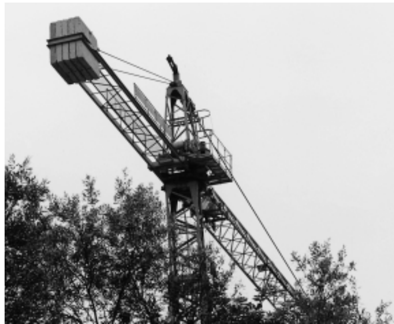
Una grua de la construcció, en unes obres a Santa Eulària.
