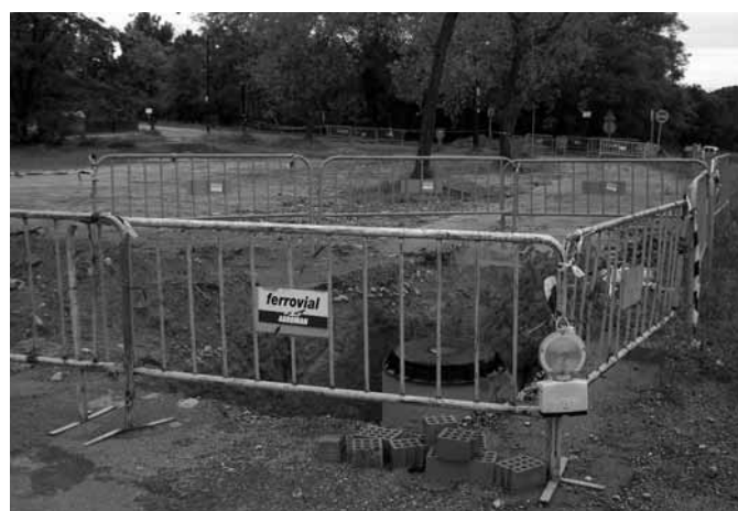
Les obres de la connexió ATLL, a la Vall
