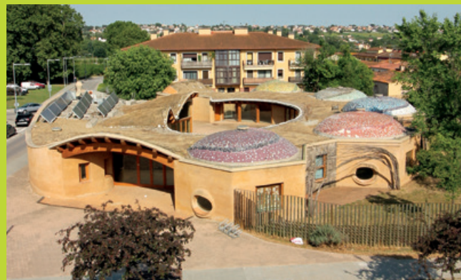
L'antiga escola bressol durà a terme obres de reparació
