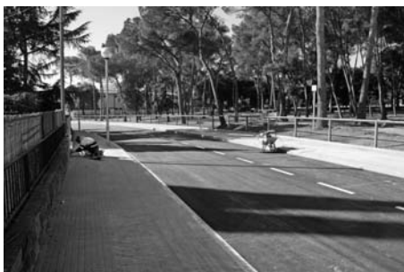
Obres d'urbanització del carrer del Forn.
