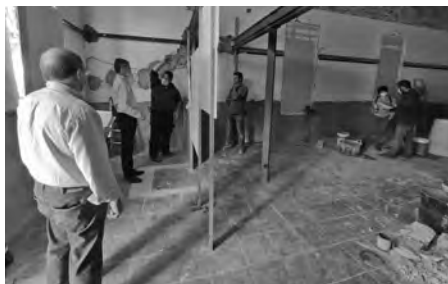
Seguiment de les obres del nou plató.
