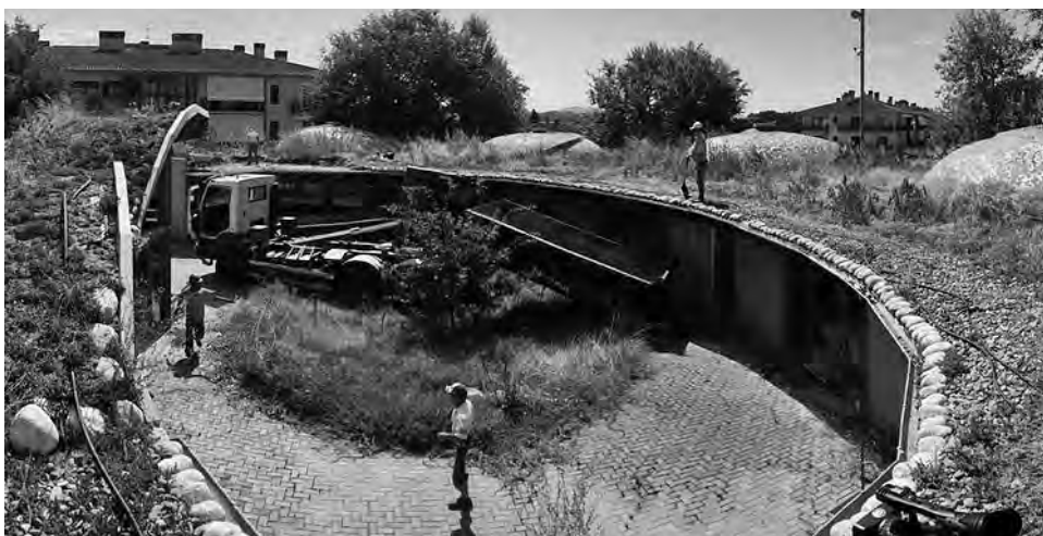
Obres de la coberta de l'equipament municipal de La Font del Rieral.
