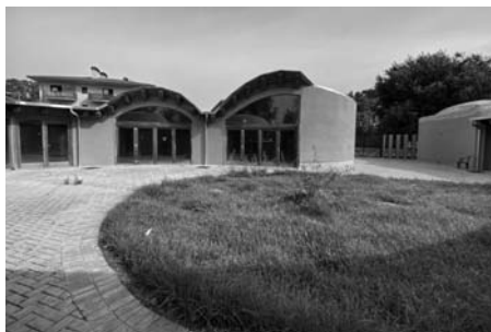
Finalitza la primera fase de les obres d'adequació de la Font del Rieral.
