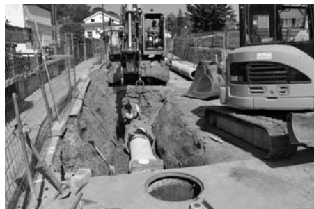
Obres del col·lector del Torrent de les Tres Pedres.
