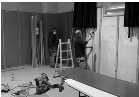
Obres de millora a la Sala Muriel Casals.
