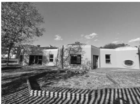
El Ple aprova una modificació de crèdit per la segona fase de la reforma de la Font del Rieral.
