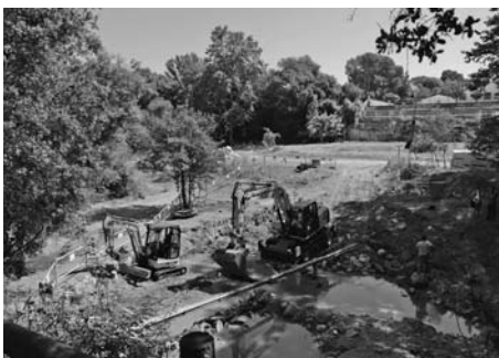
Obres al gual de Sant Cristòfol.
