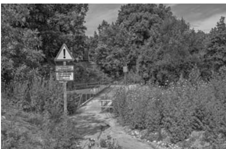
Sobre el remodelat gual de Sant Cristòfol.
