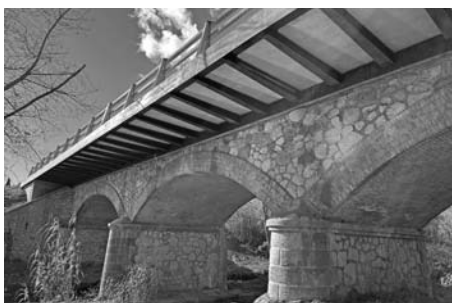
El camí de vianants creua el pont de Ca l'Unyó.
