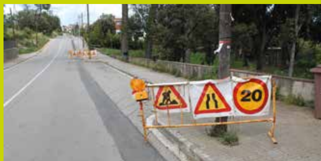
Obres del Gas Natural al Camí de Caldes
