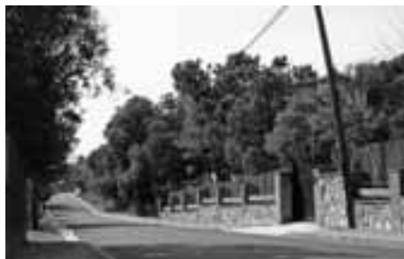
El carrer Farigola acabat de pavimentar.
