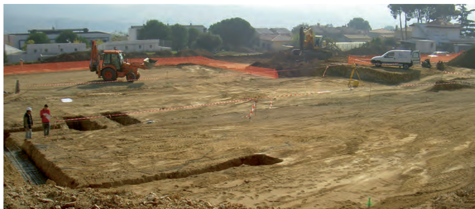
Finalment les obres de la segona escola es van iniciar al setembre.
