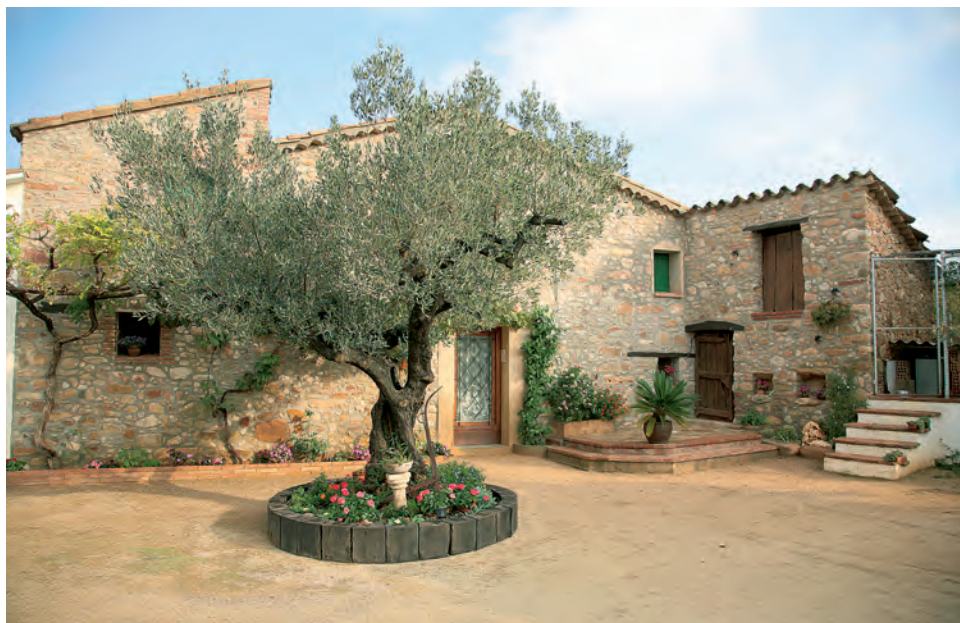
Façana actual de Can Just.
