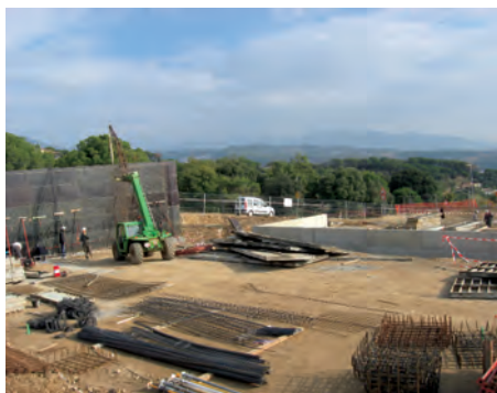
Els nens i nenes de 1r. i 2n. del CEIP Santa Eulàlia han visitat les obres de la nova escola.
