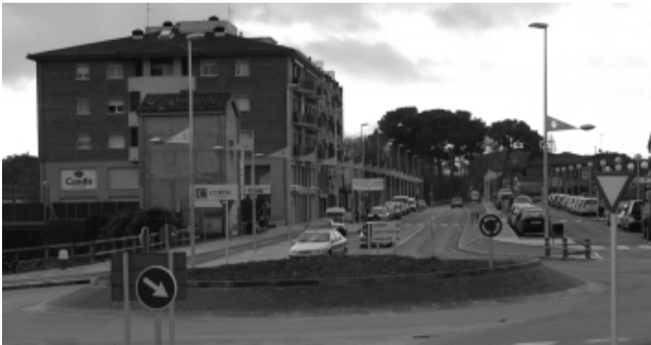
Les obres a la carretera, pràcticament acabades
