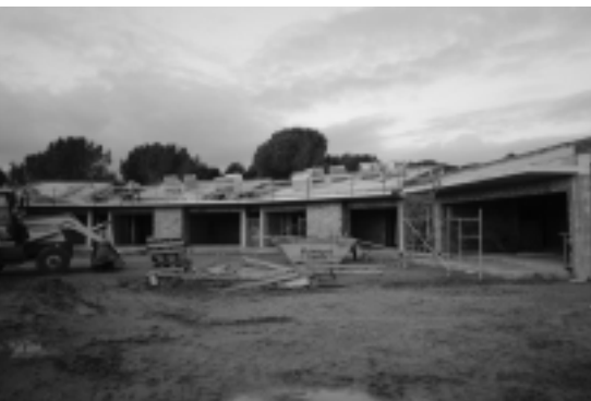
Les obres de l'Escola bressol.
