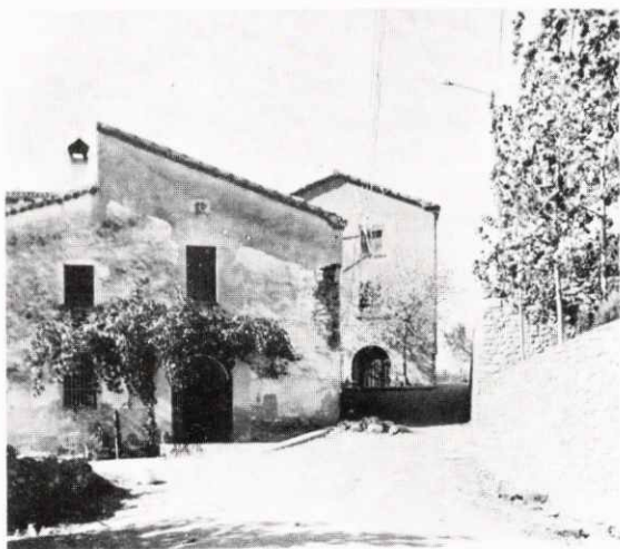
L'antiga façana de Can Colom
