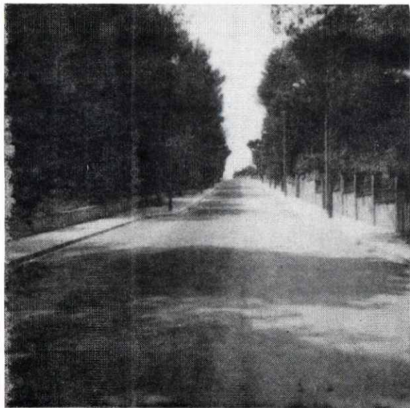
El nou Camí de Caldes va avançant.
