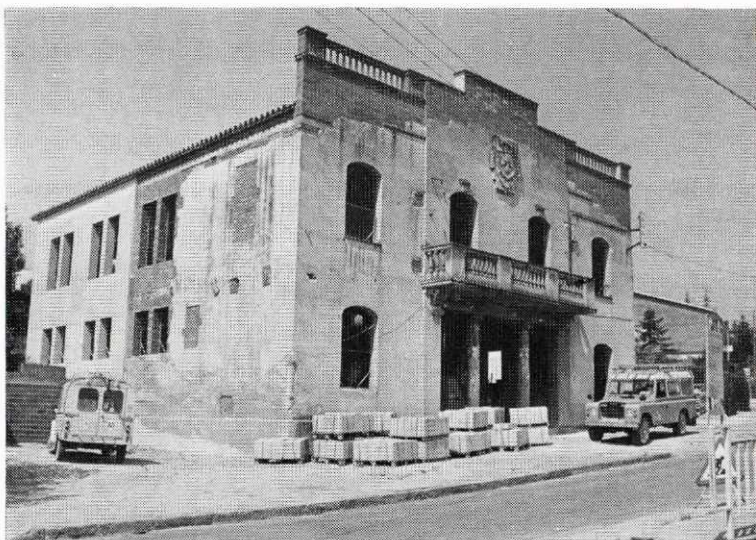
Reforma i ampliació de la Casa Consistorial.
