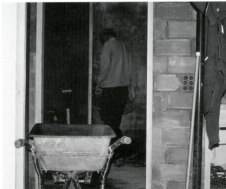
Les obres comportaran el trasllat del Jutjat de Pau
