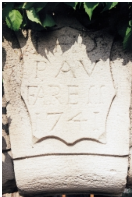
Dovella central del portal del barri.
