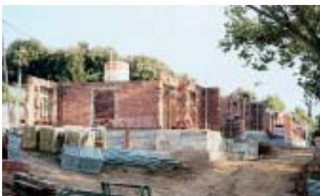
Els habitatges Socials en construcció.
