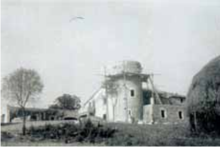
La construcció de la torre el 1954. (Foto: Josefina Coromina).
