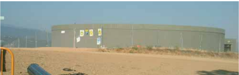
Nou dipòsit pel subministrament d'aigua potable.
