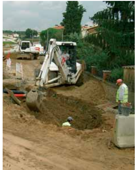
Les obres d'urbanització i millora no han parat durant tot l'any en diferents indrets del poble.
