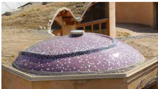
Una de les cúpules per on es filtra l'aigua de pluja
