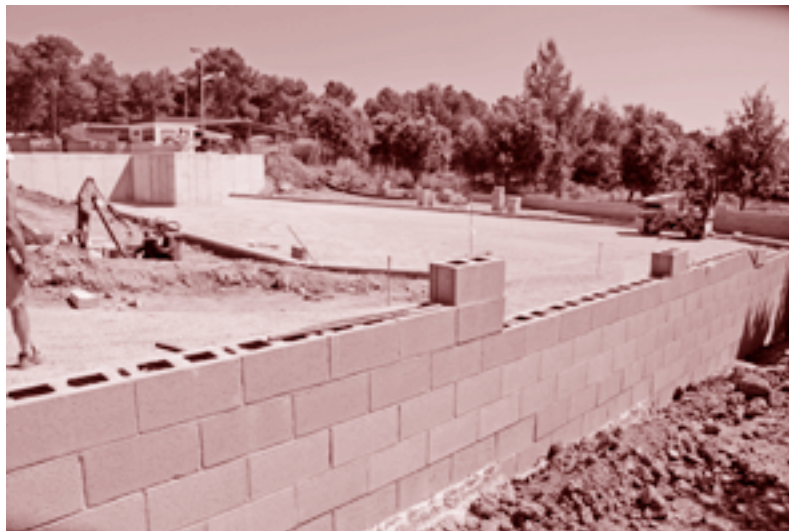
Les obres, al costat de l'actual deixalleria
