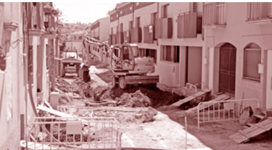
Les obres al carrer del Mig es van iniciar a finals de juny
