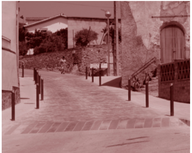
Les obres han deixat aquesta imatge a l'alçada de Ca l'Espardenyer
