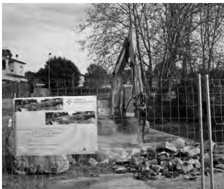
El qual de Sant Isidre sobre el Tenes és on han començat les obres del pla d'adequació de tota la llera del riu al seu pas per Santa Eulàlia.
