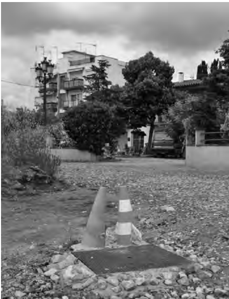
El sector de Can Careta ja disposa de connexió a la xarxa de clavegueram.
