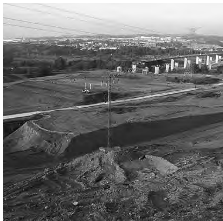
Exemple de l'afectació del Quart Cinturó en el tram Abrera-Terrassa.
