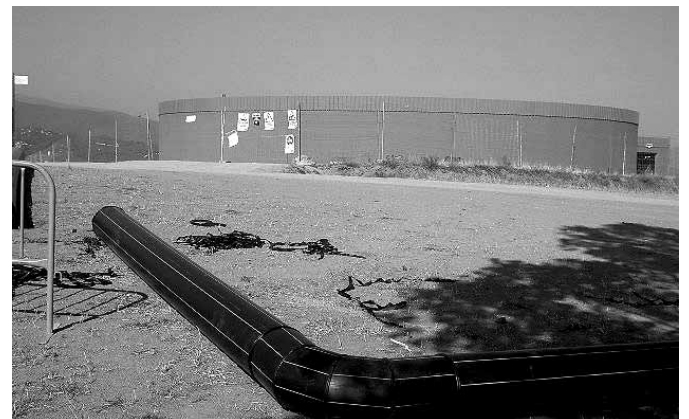
Les obres al dipòsit de Rosàs
