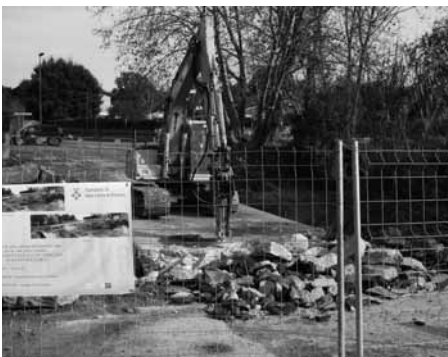
Obres al gual de Sant Isidre.
