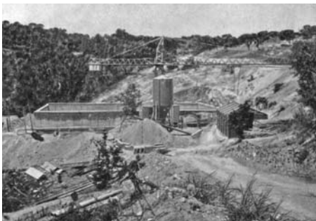
Construcció de les nova piscina de competició a la urbanització la Primavera.
