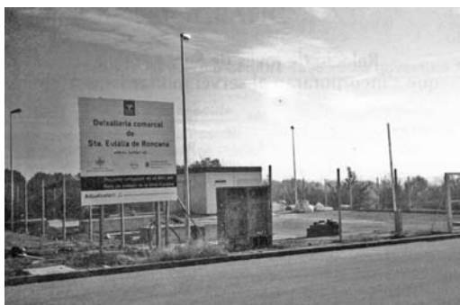
La deixalleria de Santa Eulàlia, en construcció
