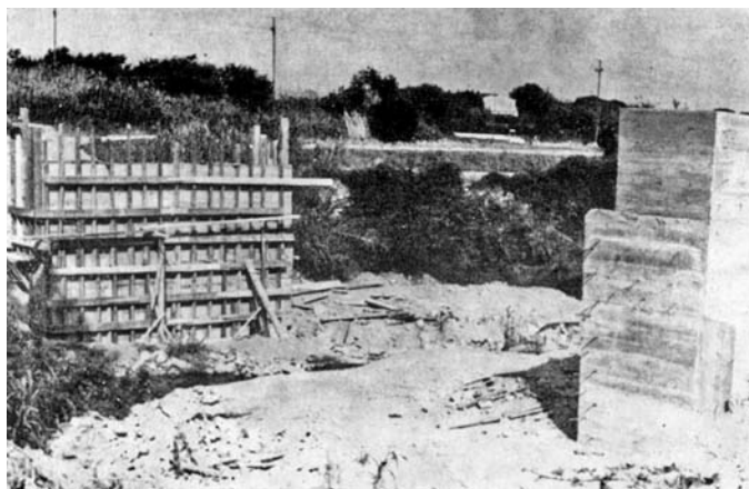
El nou pont de Can Donat en construcció.
