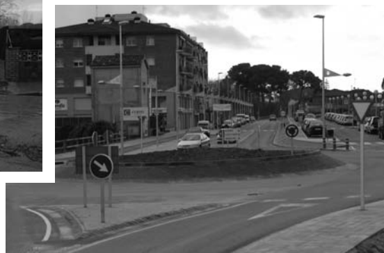
Les obres de la carretera, pràcticament acabades.
