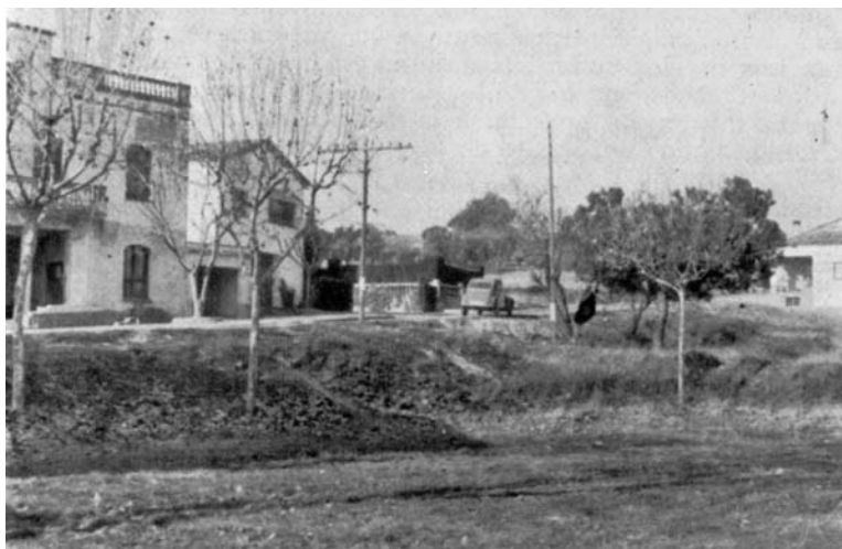
Vista parcial de la plaça de l'Ajuntament abans de les obres d'urbanització.
