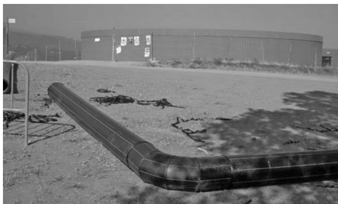
Nou dipòsit de subministrament d'aigua potable.
