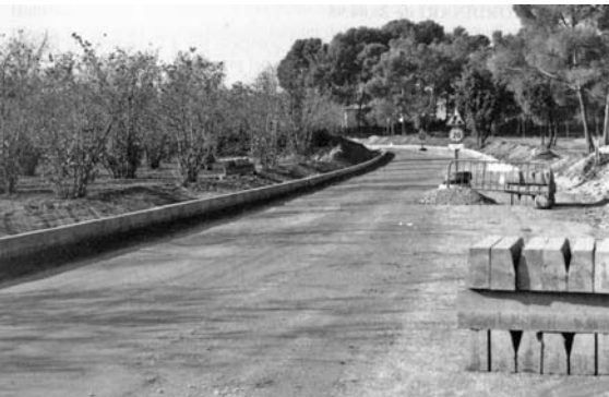
Obres de pavimentació del camí de la Serra.
