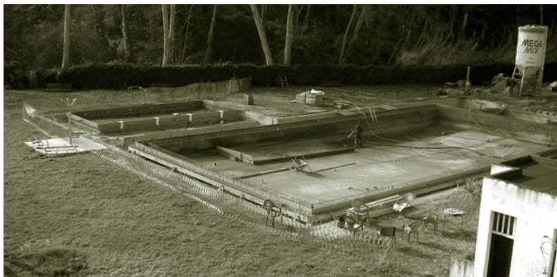
Les obres a les piscines municipals Pinedes Castellet, a finals de febrer
