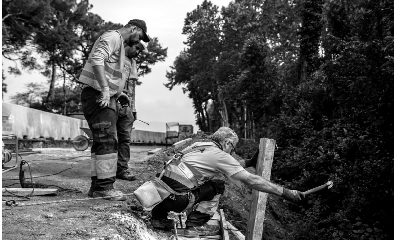
Operaris treballant al camí de vianants.
