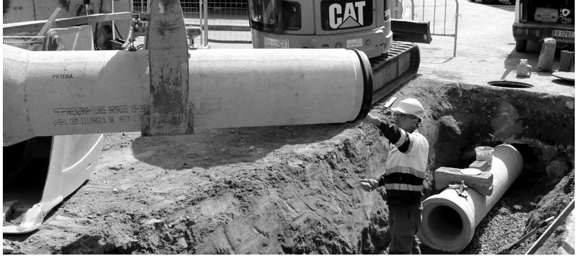
Operari col·locant la canonada que connecta amb el clavegueram del Rieral.
