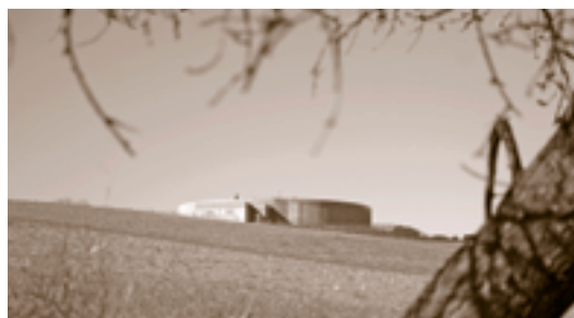
El dipòsit d'Aigües Ter-Llobregat, a Rosàs
