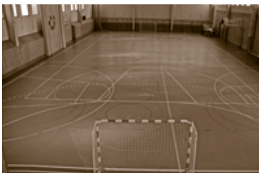
La instal·lació del parquet al pavelló es farà durant les vacances d'estiu
