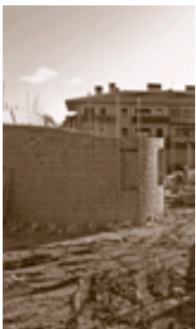
Les obres de la segona escola bressol, al Rieral
