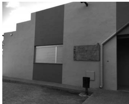
Algunes de les obres de reparació que s'han fet a l'Institut.
