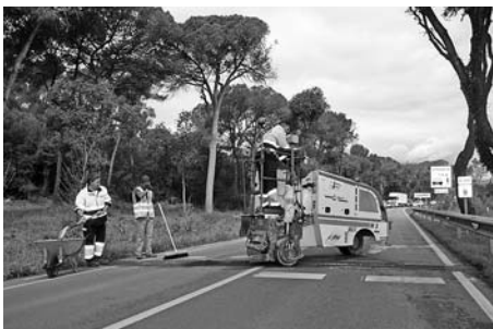
Inici de les obres de l'itinerari de vianants entre Santa Eulàlia i Lliçà d'Amunt.
