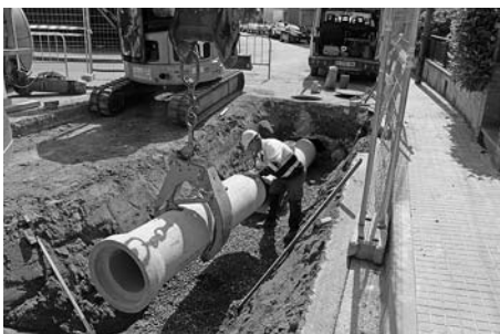
Inici de les obres del col·lector d'aigües residuals de Can Met i Can Maset.
